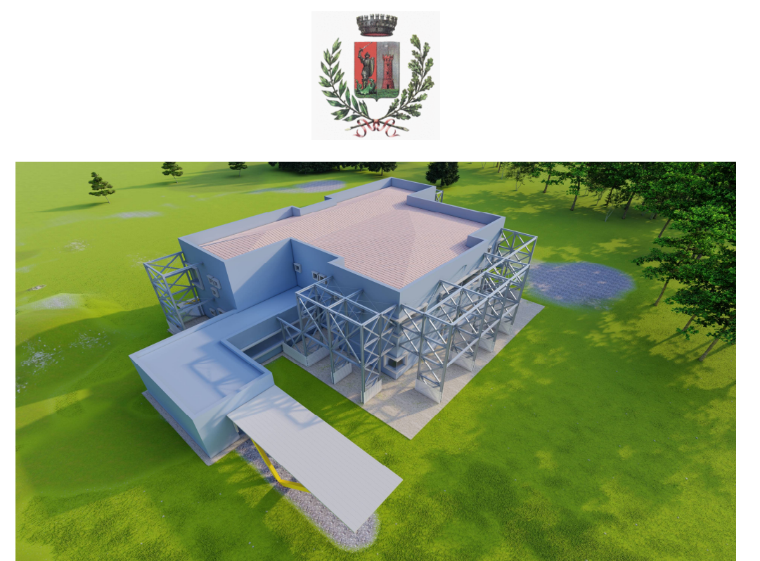
Adeguamento sismico scuola primaria San Terenziano
